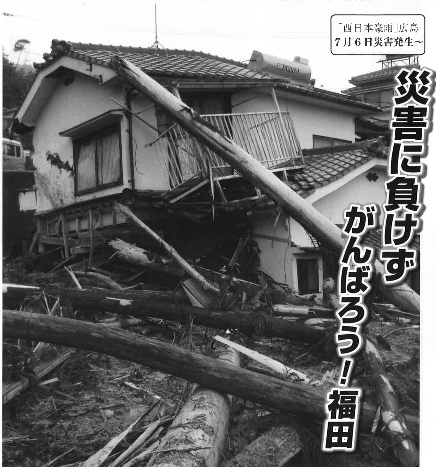
すさまじい土石流が人家を襲った（7 月 8 日撮影、福田 1 丁目・上条地区）
