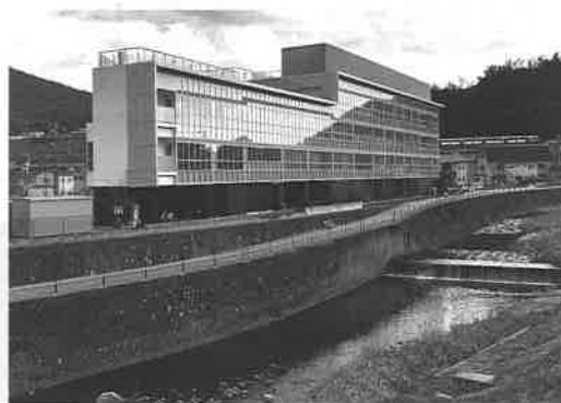
右岸に完成したカラー舗装の散歩道
